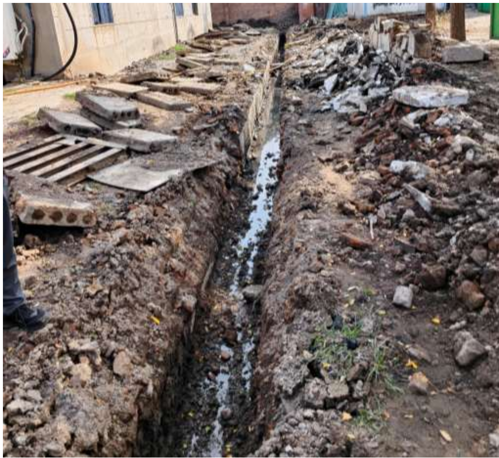
西风井工业场地防治区排水沟施工（2026 年 9 月）
