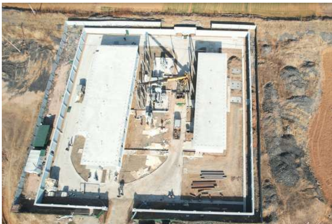
变电站防治区（2026 年 1 月）
