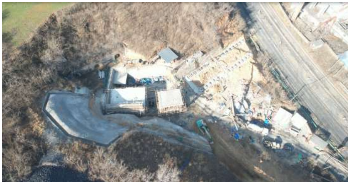
混合斜井工业场地防治区（2026 年 1 月）
