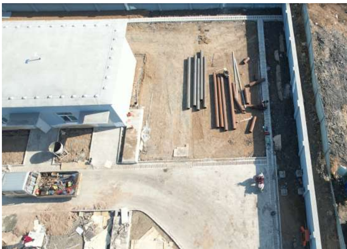
变电站防治区排水沟（2026 年 1 月）
