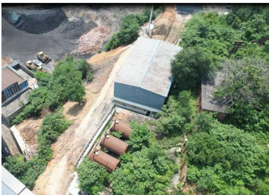
混合斜井场地防治区截水沟（2026 年 6 月）
