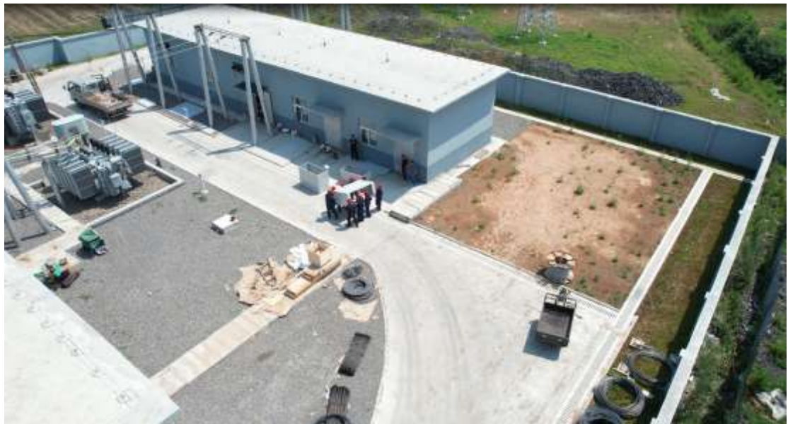
变电站防治区排水沟（2026 年 6 月）
